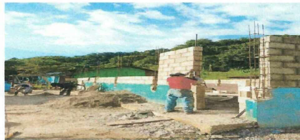
Foto 2: COLOCACION DE HILADAS DE BLOCK Y FORMALETAS
