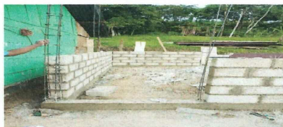
Foto 4: AVANCES DE LOS TRABAJOS DE COLOCACION DE BLOCK
