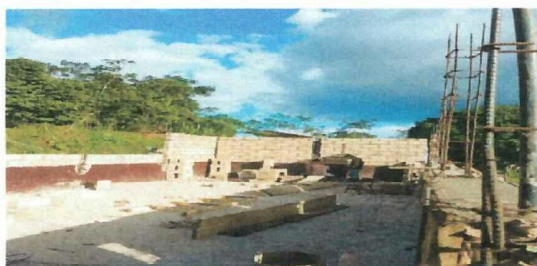
Foto 3: VISTA DE LAS HILADAS DE BLOCK EN METROS LINEALES
