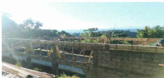
Foto 5: VISTA DE LOS TRABAJOS AVANZADOS DE SOLERA Y CORONACION.
