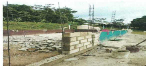
Foto 6: COLOCACION DE FORMALETAS DE SOLERA Y COLUMNAS.
